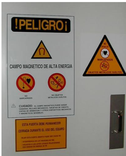
Figura 25. Advertencia ubicada en la puerta de acceso de la unidad de RM.
