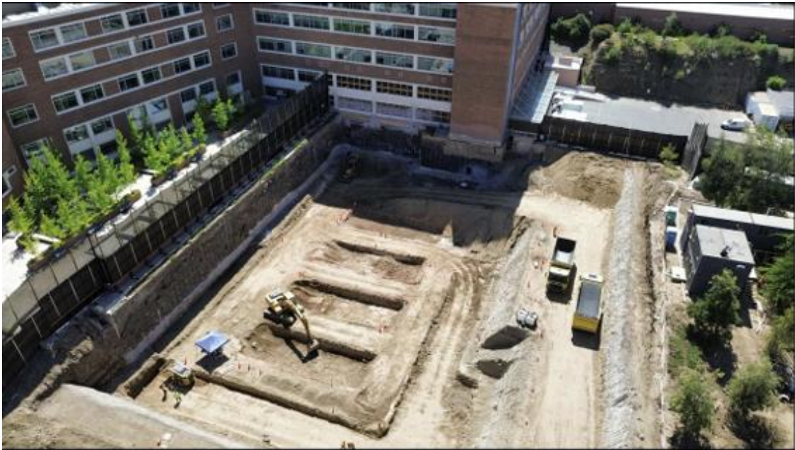
Avance en ejecución de excavación y fundaciones.
