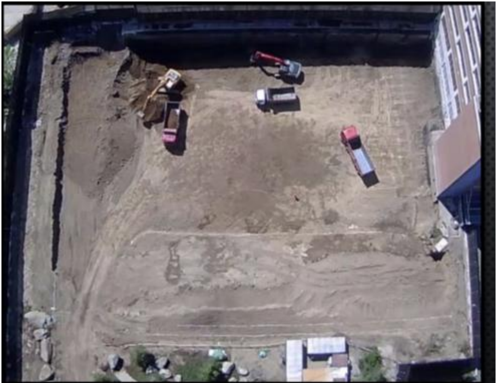
Avance en ejecución de cierres perimetrales y excavación.
