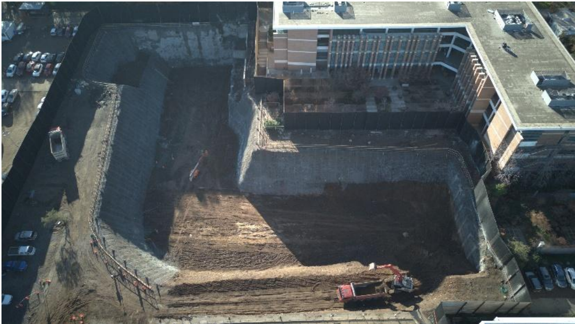
Avance en excavación.
