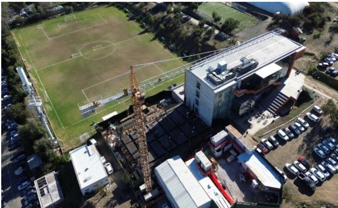
Avance en ejecución de fundaciones y construcción.
