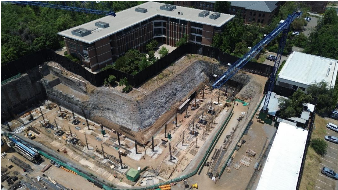
Avance en ejecución y excavación de fundaciones.
