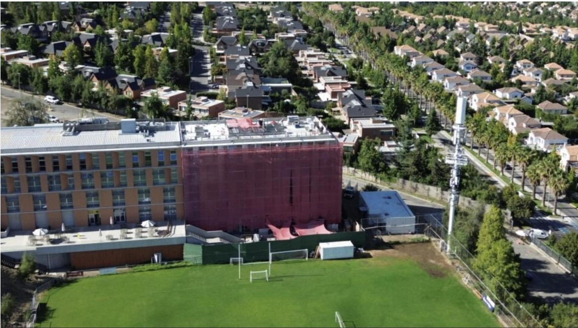
Avance en fachadas e instalaciones
